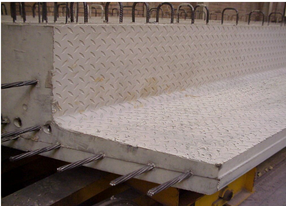
Obrázok 5.1: Detail povrchu prefabrikátu zo SZB plneného pod debnením.
