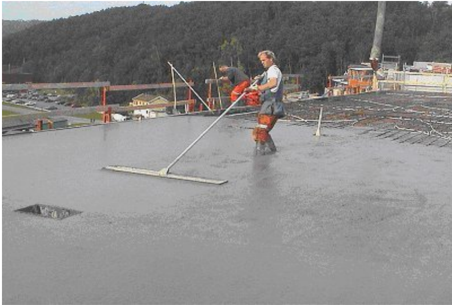
Obr. 11.1 Hladenie povrchu SZB striedavými pohybmi za pomoci hladiacej dosky
