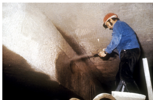
Obrázok CS1.3: Oprava prvkov torkretovaním (za použitia striekaného betónu) (so zvolením DBV, Nemecko)
