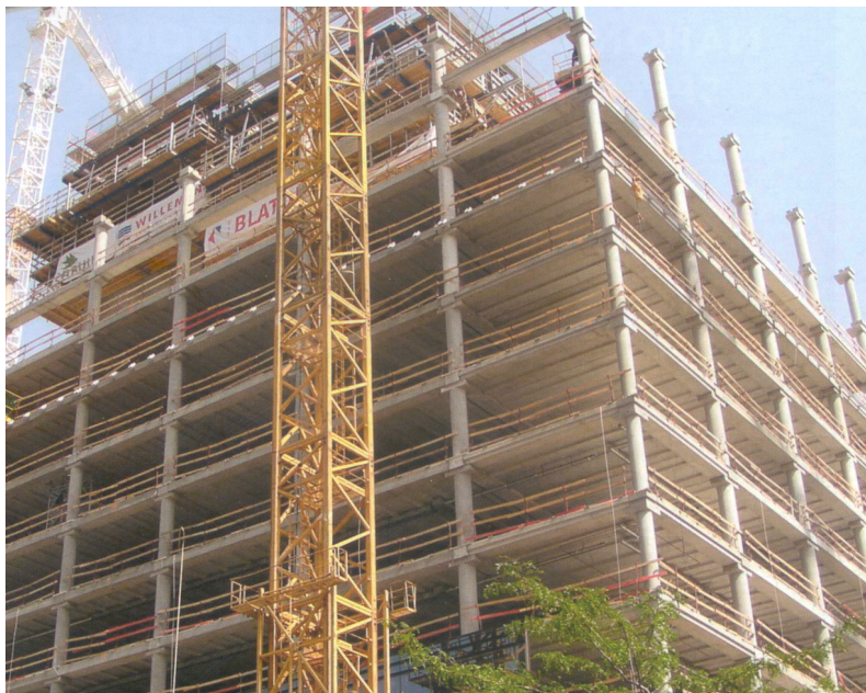
Obrázok 1.3: Veže „North Galaxy Towers“ v Bruseli. Táto 30-poschodová budova zo železobetónu spĺňa terajšie prísne požiadavky na odolnosť voči ohňu (REI 120); stĺpy sú zhotovené z vysokopevnostného betónu triedy C80/95. (so zvolením ERGON, Belgicko)
